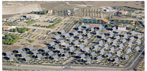
Huerto Solar La Vega: 346,5 kWp
